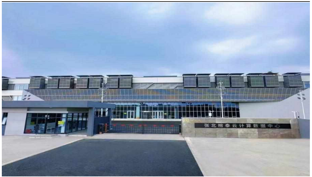
图20：张北榕泰算力数据中心一期完成交付
