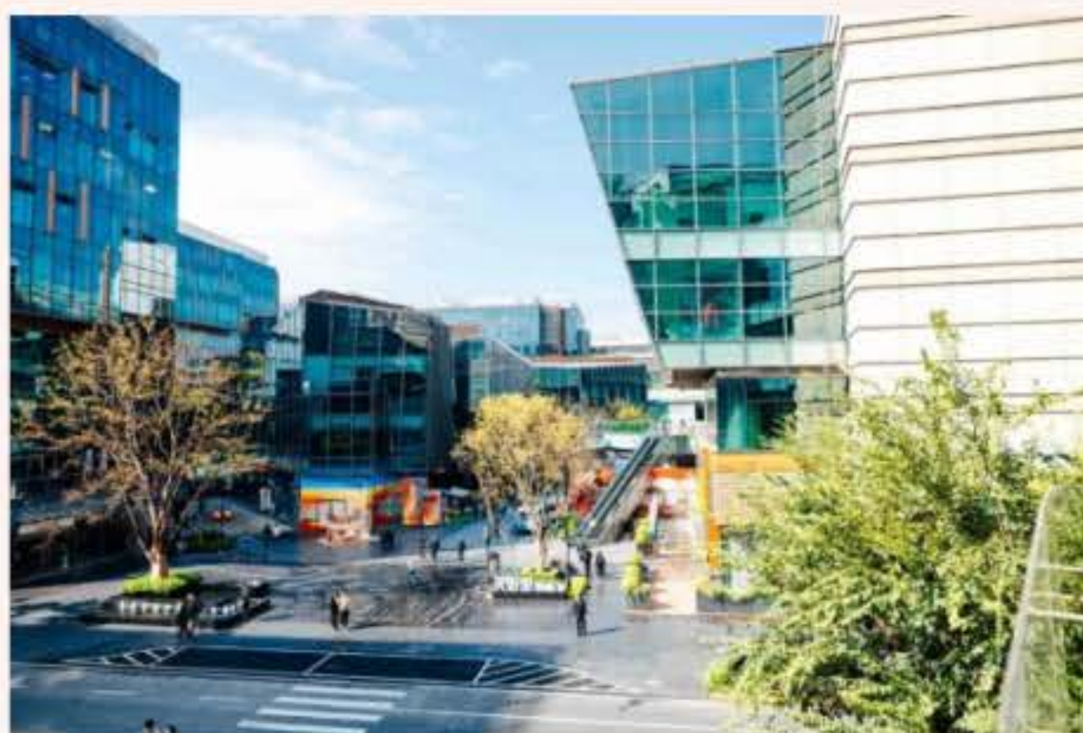
图 55 虹桥天街改造后实景图
