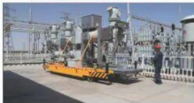
HGIS设备安装运输就位装备
