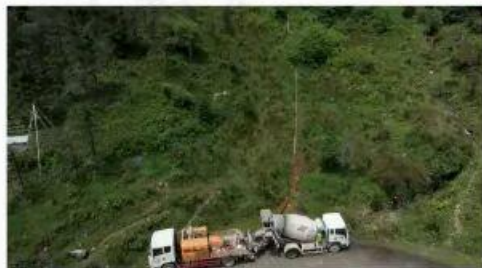
混凝土泵送施工
