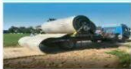
临时道路铺路机
