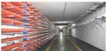
电缆（GIL）工程
