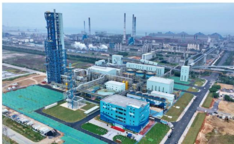
图 70 湛江钢铁百万吨级氢基竖炉项目实景
