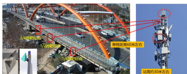
图4-30 桥梁微观变形监测应用案例
