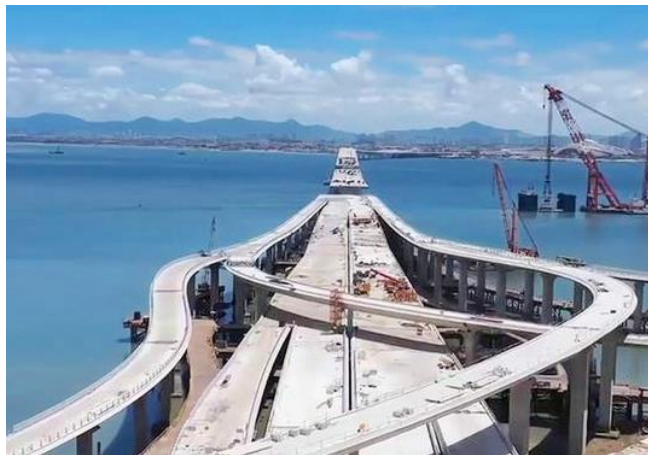
图 9 夏金跨海大桥开始修建
