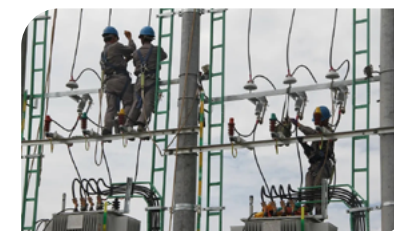
供电人员开展电烤房业扩延伸项目建设
