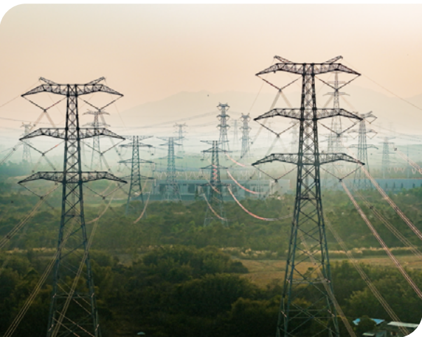
广东 500 千伏鹅凰开关站及相关线路升级改造工程
