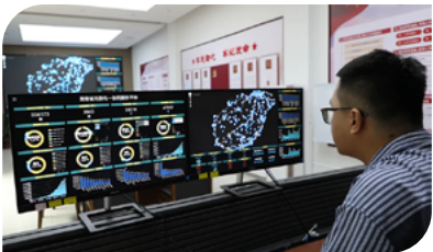
工作人员在海南省充换电“一张网”示范基地平台监控室查看平台运行情况
