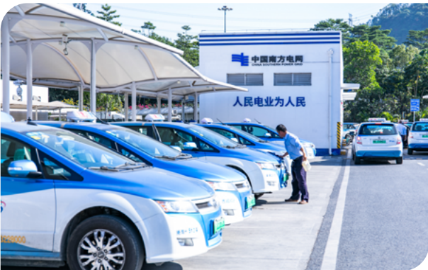
南网电动民乐 P+R 充电站，是目前亚洲最大的集中式充电站
