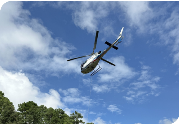
重载飞行器吊运线路施工材料
