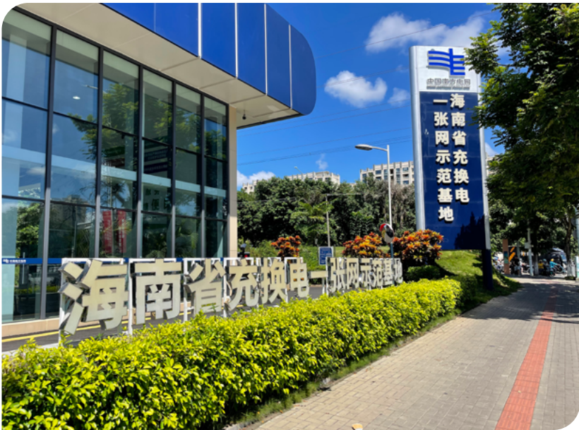
海南省充换电“一张网”示范基地外景
