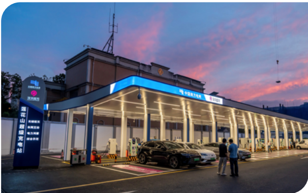
改造升级后的深圳莲花山超充站为车主提供了更好的充电体验
