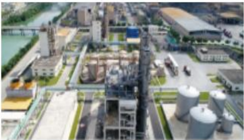
东阳光制冷剂产业
