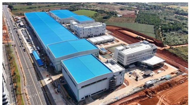
图 31：青钠能源项目现场
