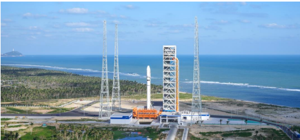
图：海南商业航天发射场二号工位
