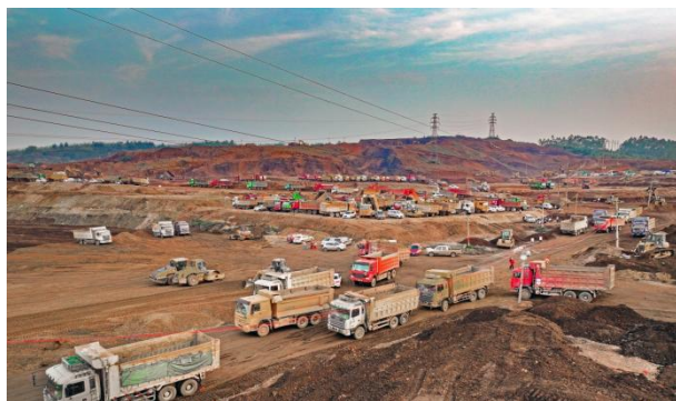
图65: 平陆运河沿线桂平新材料产业园加速建设
