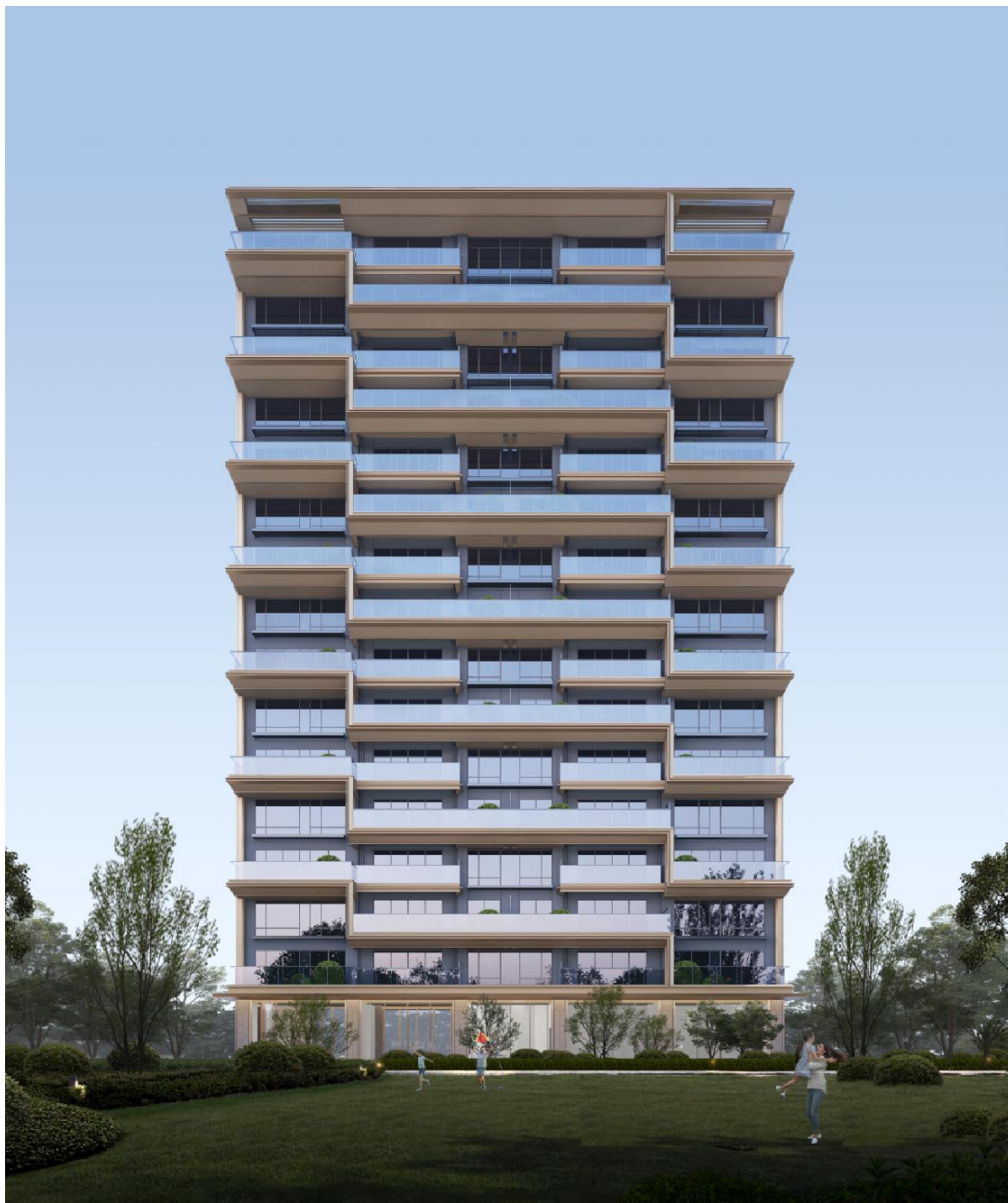
图：嘉兴馥香园样板间实景
