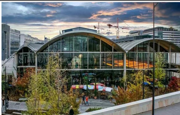
图表 43. 巴黎 Station F：由老火车站翻新改造为世界最大的初创企业孵化中心
