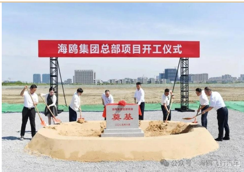
图 7: 海鸥集团总部项目开工
