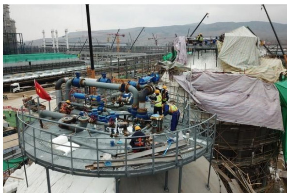
图 37：2022 年 4 月青海丽豪施工现场（一期）
