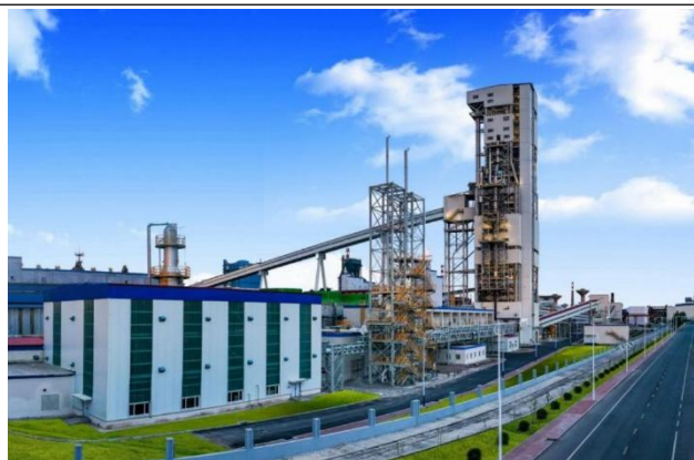
图 28：河钢集团氢冶金示范工程外景
