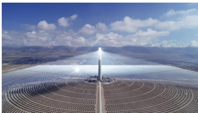
图2：中国德令哈 50MW 熔盐储能光热电站
