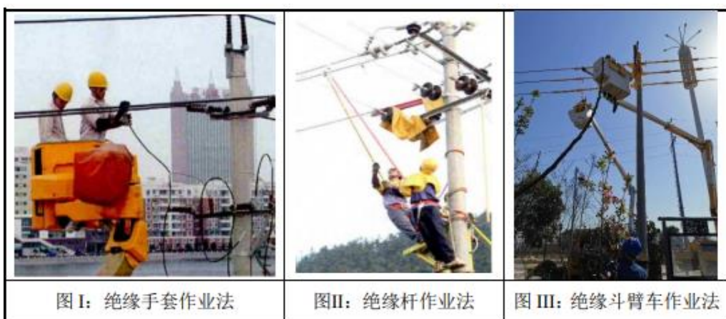
图1：带电作业法带电作业可分为三种方式
