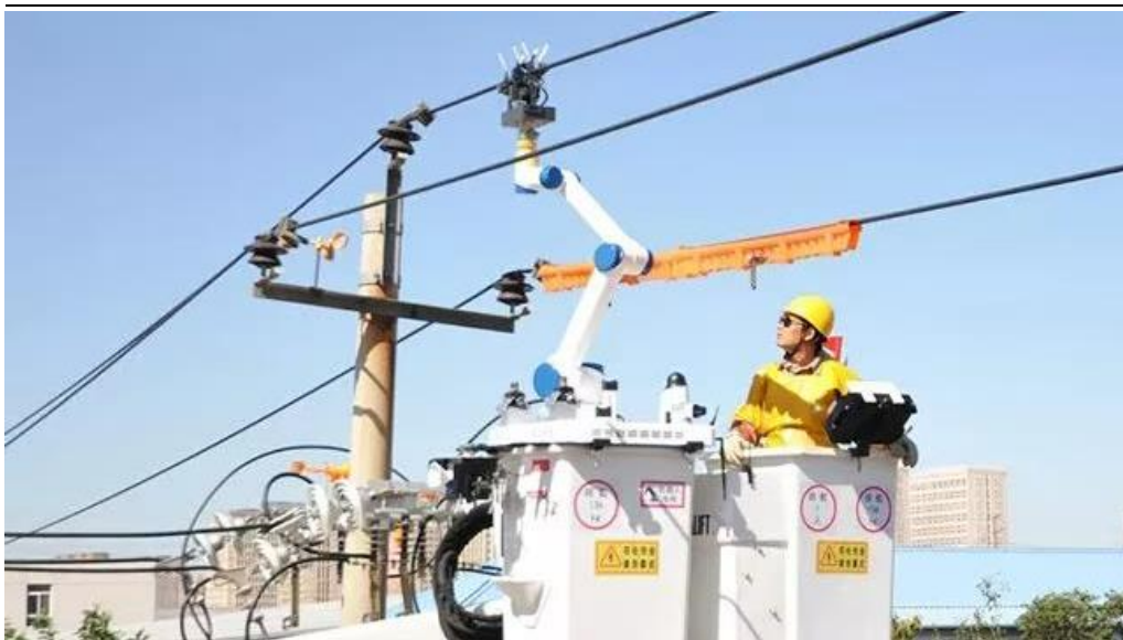
图7：国网天津城南公司应用单臂人机协同配网带电作业机器人
