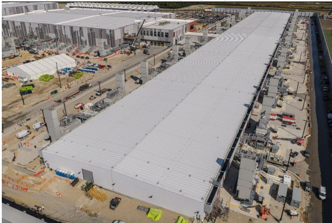
图 5：专门用于存储和处理 AI 数据中心数据的存储与计算数据中心的鸟瞰图
