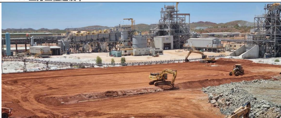
图15：P680 土方工程建设中
