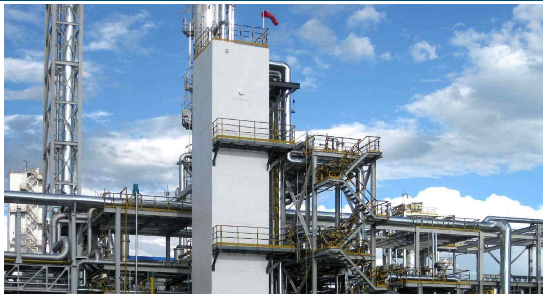
图表33：公司合成氨液氮洗成套装置示意图
