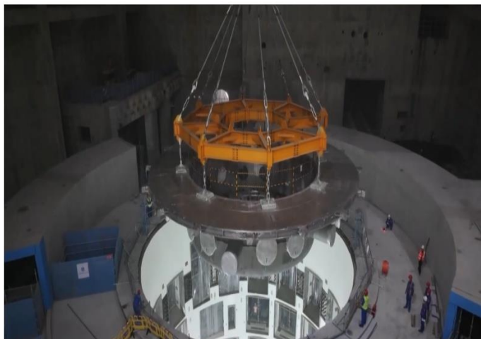
图4: BEST 项目 400 余吨杜瓦底座成功安装就位
