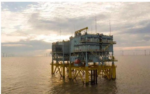
图19: 公司承建协鑫如东 H13#海上风电项目
