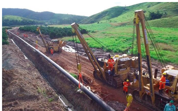
图36: Concremat 承接巴西陆上天然气管道 3 号线 EPC 工程
