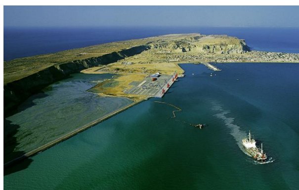
图34：公司承建巴基斯坦瓜达尔港工程
