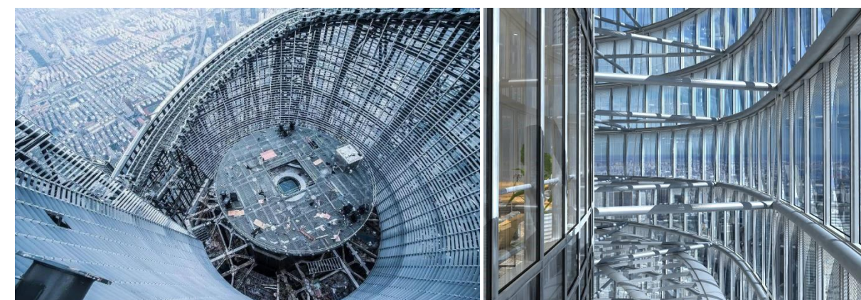
图 7：上海中心大厦的双层玻璃幕墙系统
