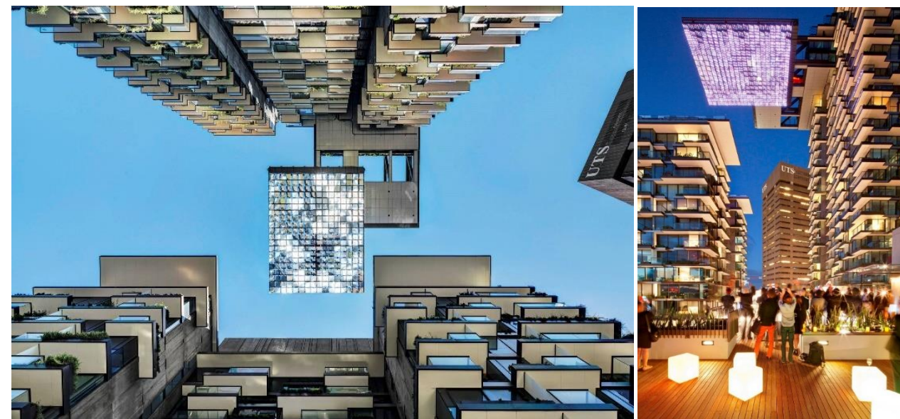
图 22：中央公园一号的日光反射装置
