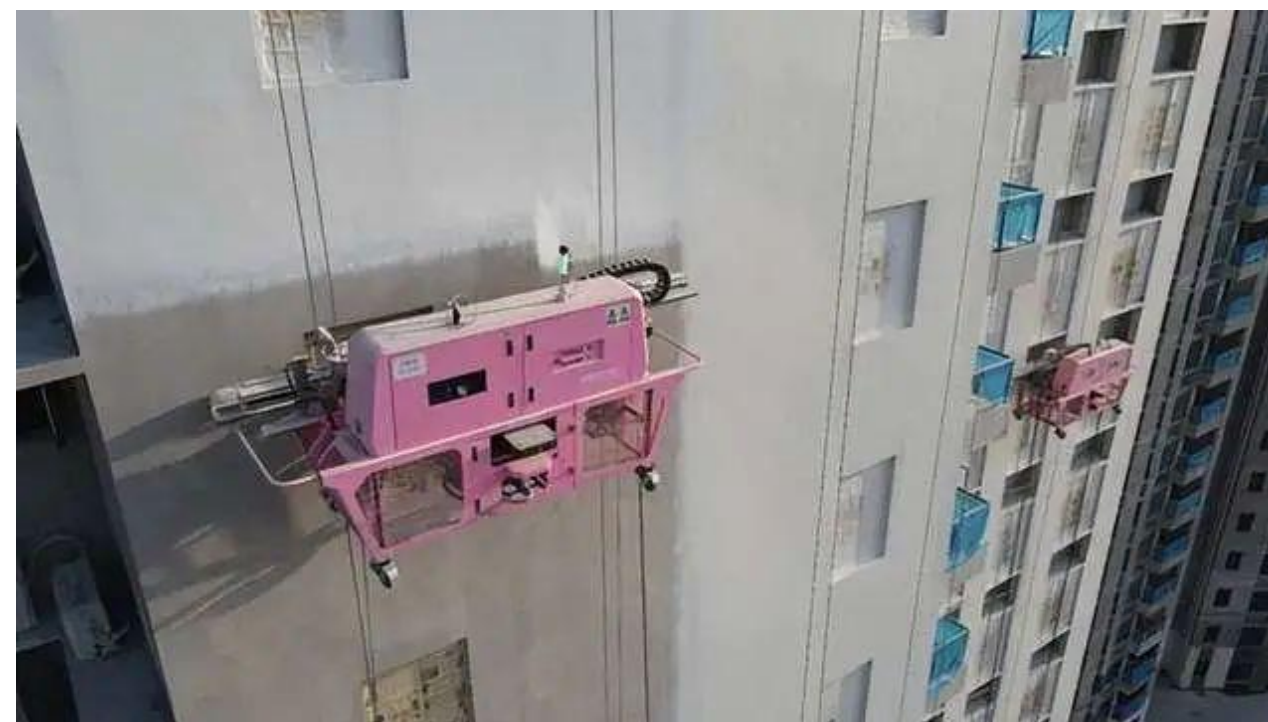
图 42：爬升式乳胶漆外墙喷涂机器人
