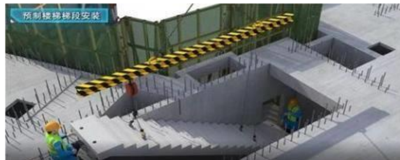
图 40：预制楼梯安装模拟
