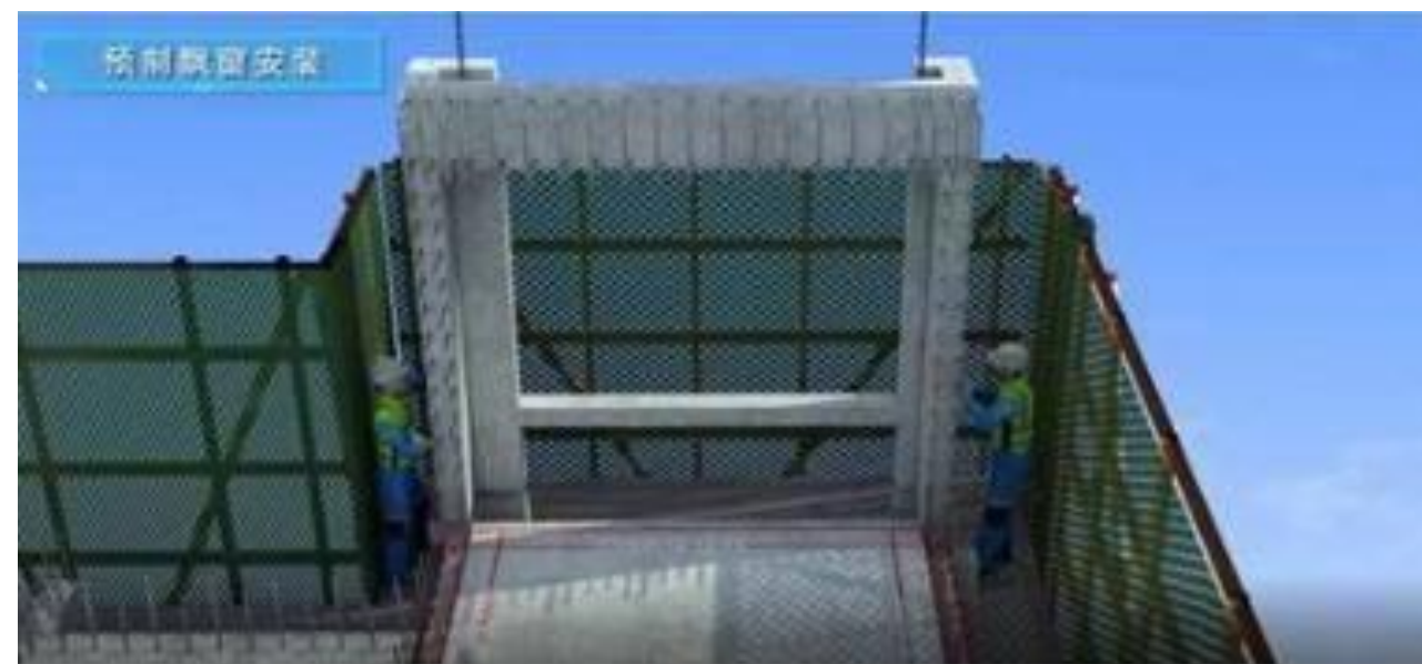
图 40：预制楼梯安装模拟
