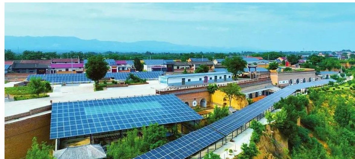
图 10：庄上村“光储直柔”能源系统
