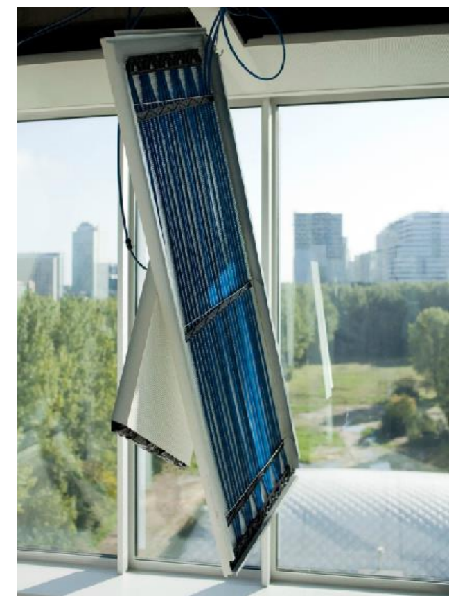
图 3：天花板中的地下含水层储能的长距离蓝色管网
