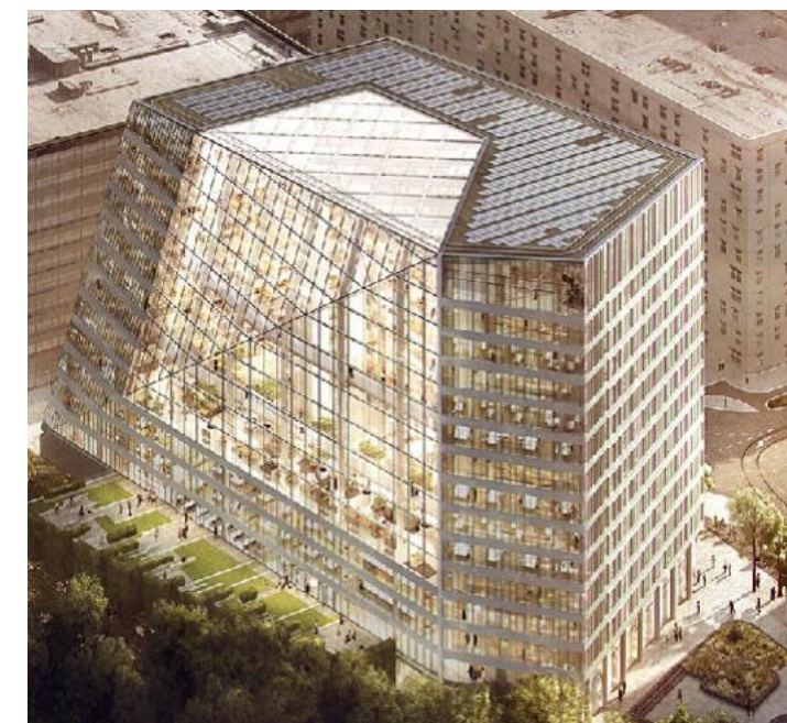
图 6：The Edge（前沿）大厦屋顶太阳能光伏电板
