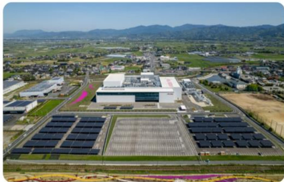
图 17：资生堂福冈 Kurume 工厂的太阳能发电设施
