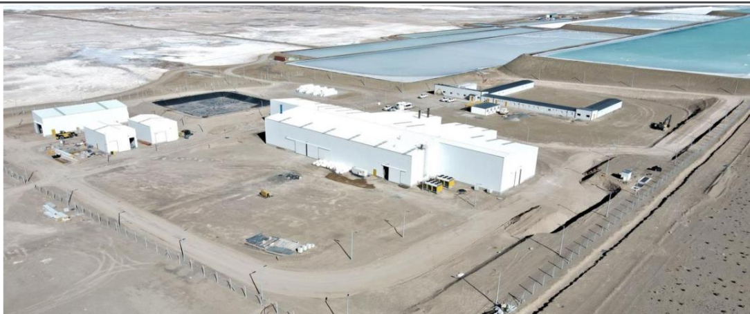
图35：Rincon 盐湖项目建设现场
