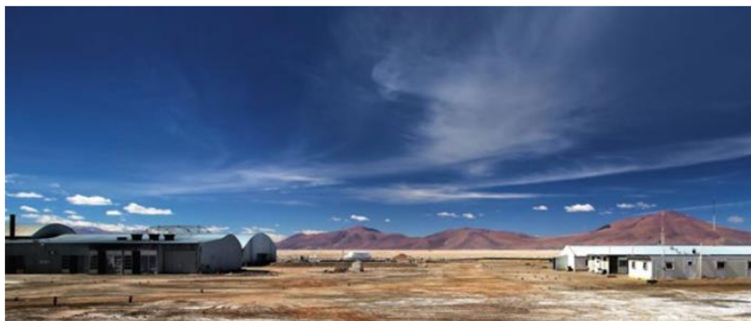
图38：Rincon 盐湖建设现场
