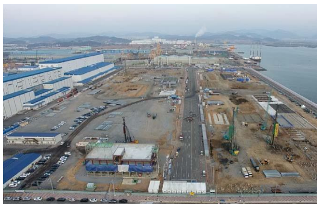
图14：光阳港氢氧化锂加工厂正在建设
