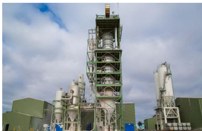
图15：采用 Calix 研发的闪速燃烧技术的电窑
