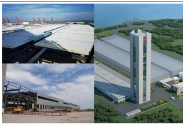
图 42：建设中的射阳生产基地
