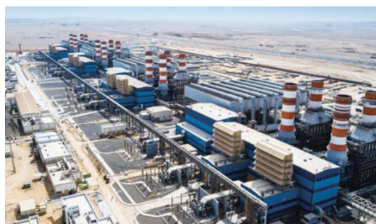
图22: 埃及新首都项目（直接空冷系统）
