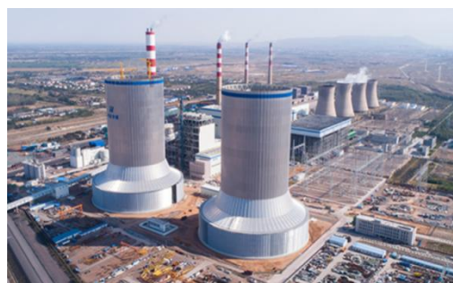
图23: 华能集团宁夏大坝电厂（全钢结构间接空冷系统）
