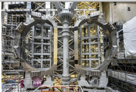
图 13: ITER 建设实景
