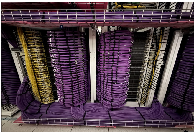
图 1-6 铜缆和光纤的部署对比 [5]
