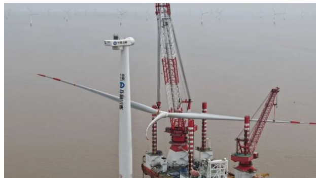
图 25：中天科技承建三峡集团江苏大丰海上风电项目
