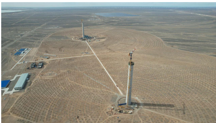
图8：“双塔一机”风光热储一体化项目施工现场
